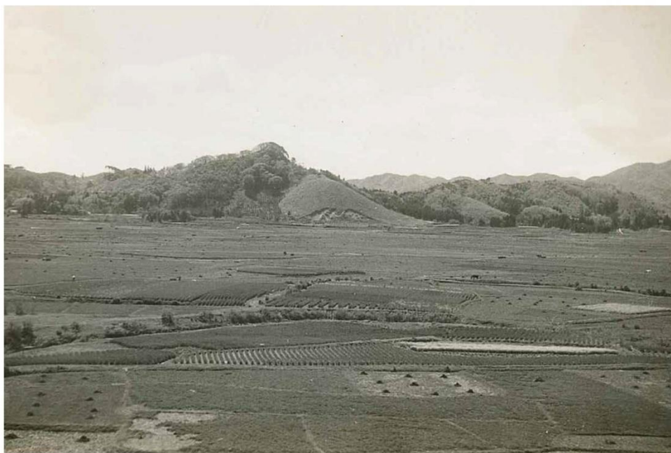
建鉾山遺跡遠景古写真(北より)
