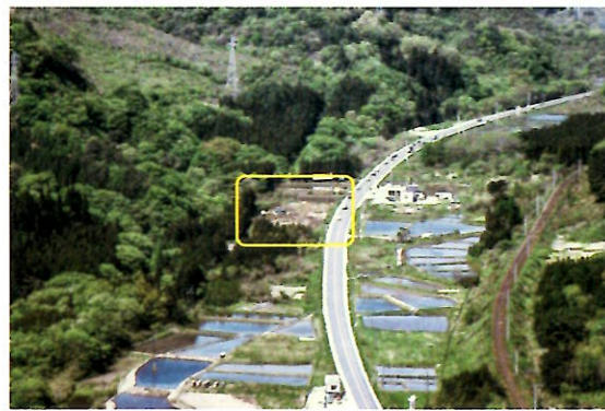
調査範囲遠景(東側より)
