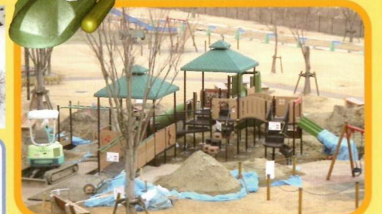
着々と進む工事。どんな形になるかわくわくしますね。
