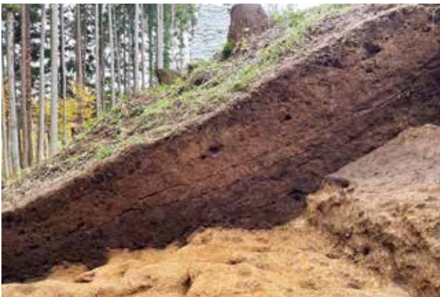
9号トレンチ南壁断面
