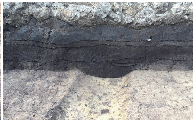
4号溝断面（東から）
