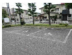
第一駐車場内
