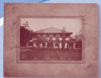
▲昭和期 修繕後の開成館
