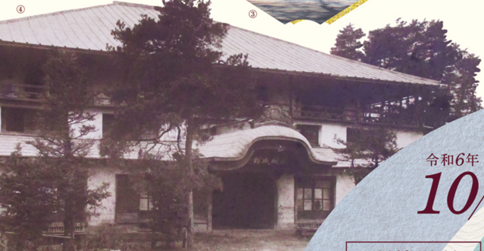
①昭和期の開成館(郡山市中央図書館蔵) ②修繕後の開成館(郡山市中央図書館蔵) ③福島県沖地震被災前の開成館 ④昭和期 修繕前の開成館
