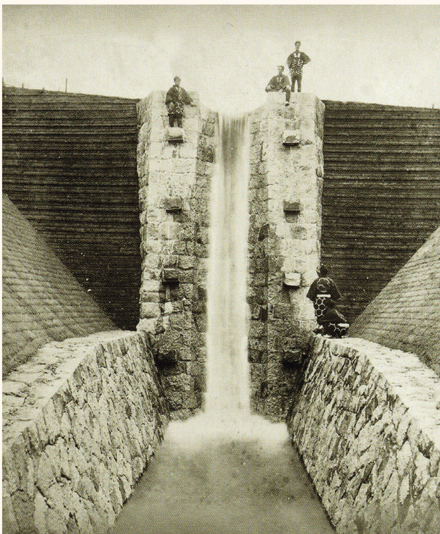
安積疏水麓山の飛瀑 皇居三の丸尚蔵館収蔵 『各地勝景五 山形・安積疏水ほか』より「猪苗代湖疏水工場撮影第十三図 郡山分水滝」 完成当時の麓山の飛瀑の姿
