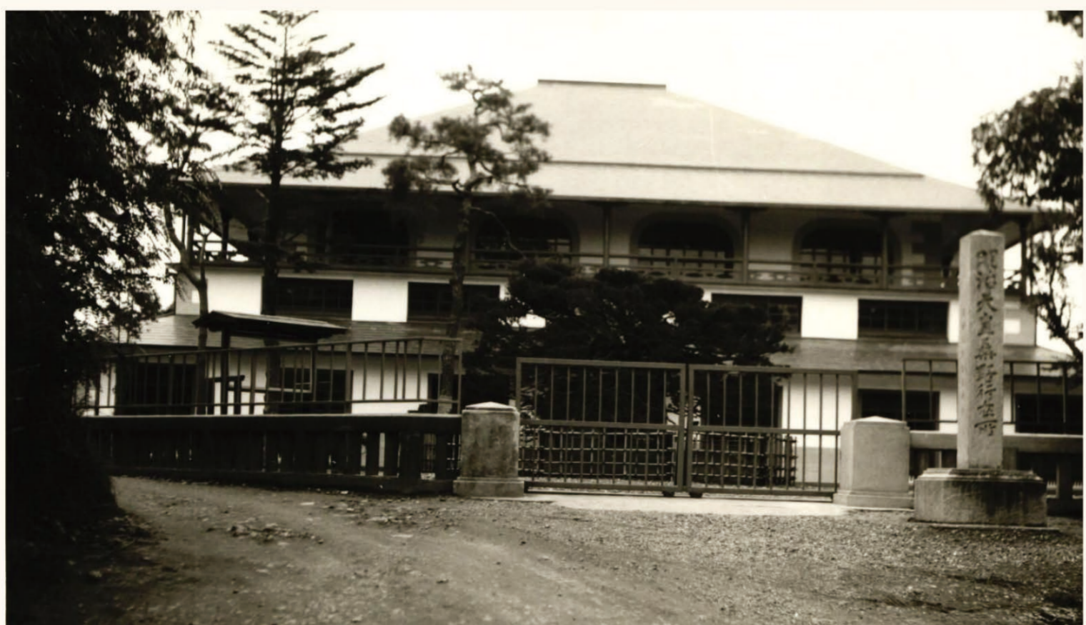
修理工事後の開成館
