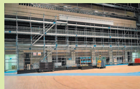
大ホール空調ダクト
