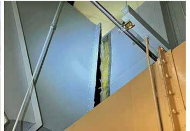
⑥ 大ホール舞台上部通路壁 損傷による傾き
