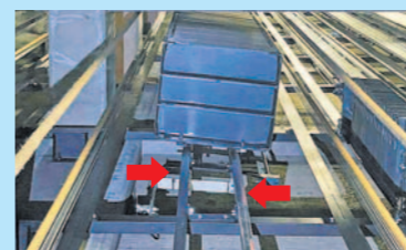
大・中ホール舞台吊物装置 昇降用レール変形
