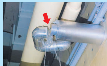
空調用冷温水配管断裂による漏水
